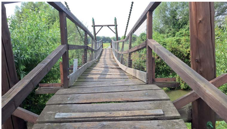
Detailní pohled na původní lávku.
